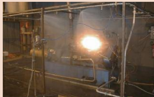
Local hydraulique – groupe électrogène
